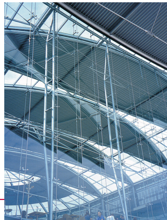
ocelová konstrukce zastřešení knihovny Forum v Norwichi (Michael Hopkins, 2001)
