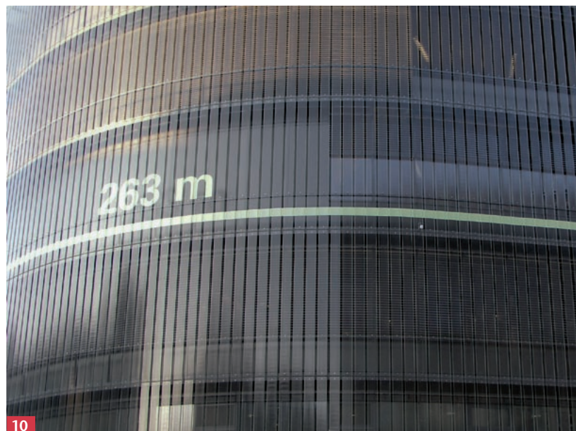
10 | dvojitá fasáda, žaluzie ovládané automaticky dle intenzity osvětlení
